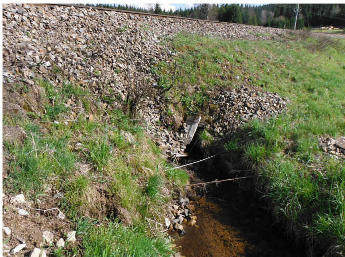
Propustek pod železniční tratí je zanesen.
